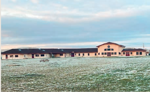
Unser Schulcampus mit 2-stöckigem Neubau
